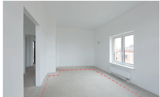
Горизонтальная разводка отопления
